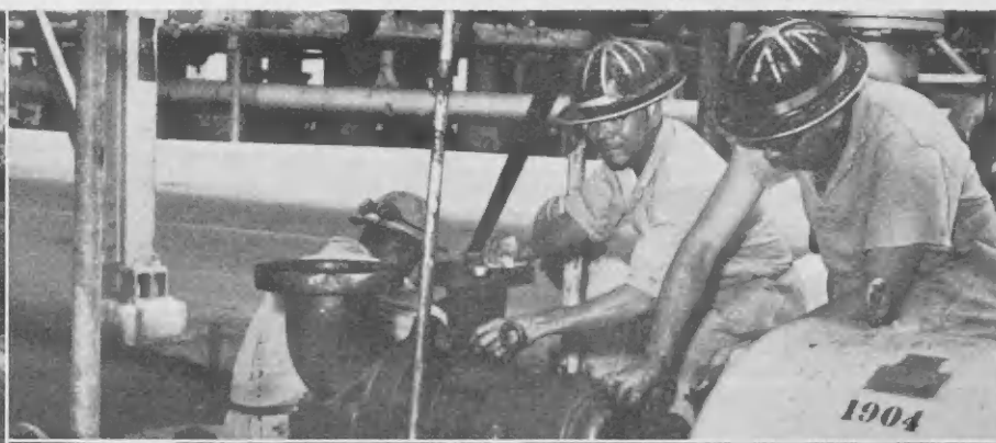
E TRABAO di reparacion ta pone un di e trabanan grandi y chikito. Un derrick ta worde usá pa consti e awantanan di p'abao pa e cilindronan reaccionador, banda robez, den posicion. E parti p'abao di e chamber, cu ta mas hancho na su rand, ta worde poní den posicion.
